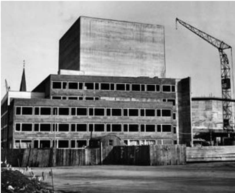
Der Neubau des Stadttheaters Trier, erbaut 1963, Blick nach Norden, Trier 1963 © Stadt Trier, städtische Denkmalpflege
